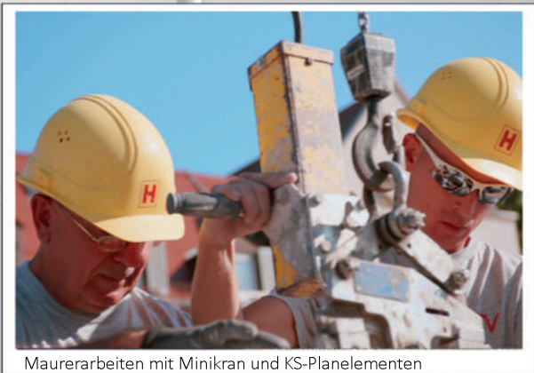
Maurerarbeiten mit Minikran und KS-Planelementen
