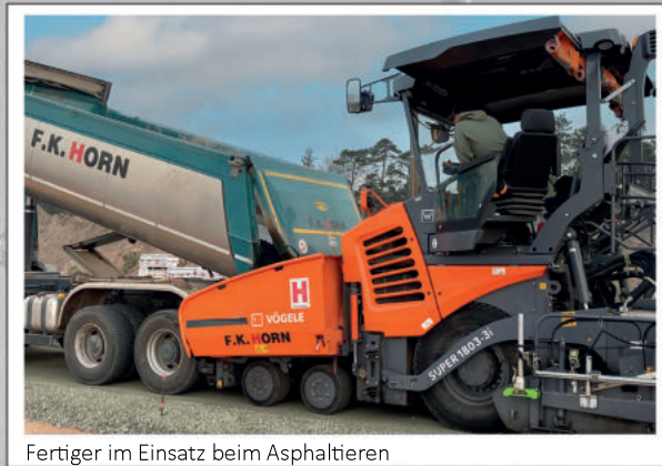
Fertiger im Einsatz beim Asphaltieren
