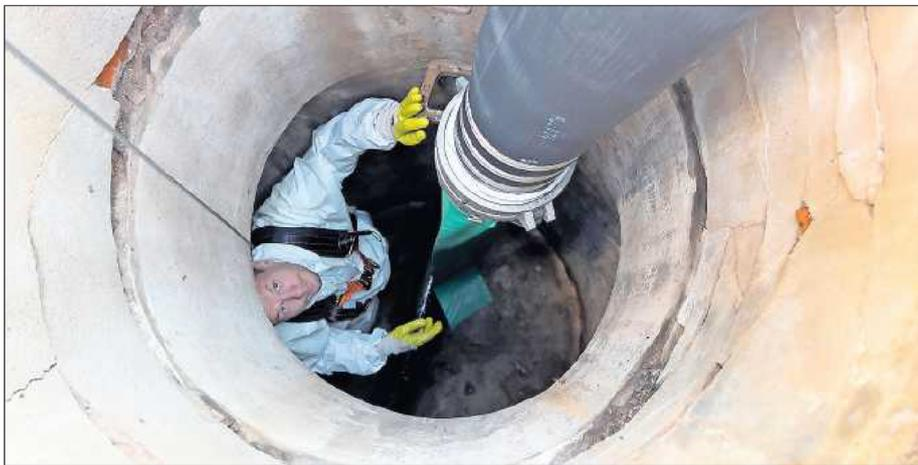
Sitzt alles? Die richtige Position für den Schlauch muss gefunden werden, damit er wie geplant in das zu flickende Rohr läuft.
