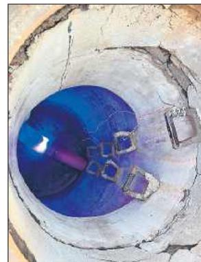
Das Harz am Rohrliner härtet durch UV-Licht aus.
